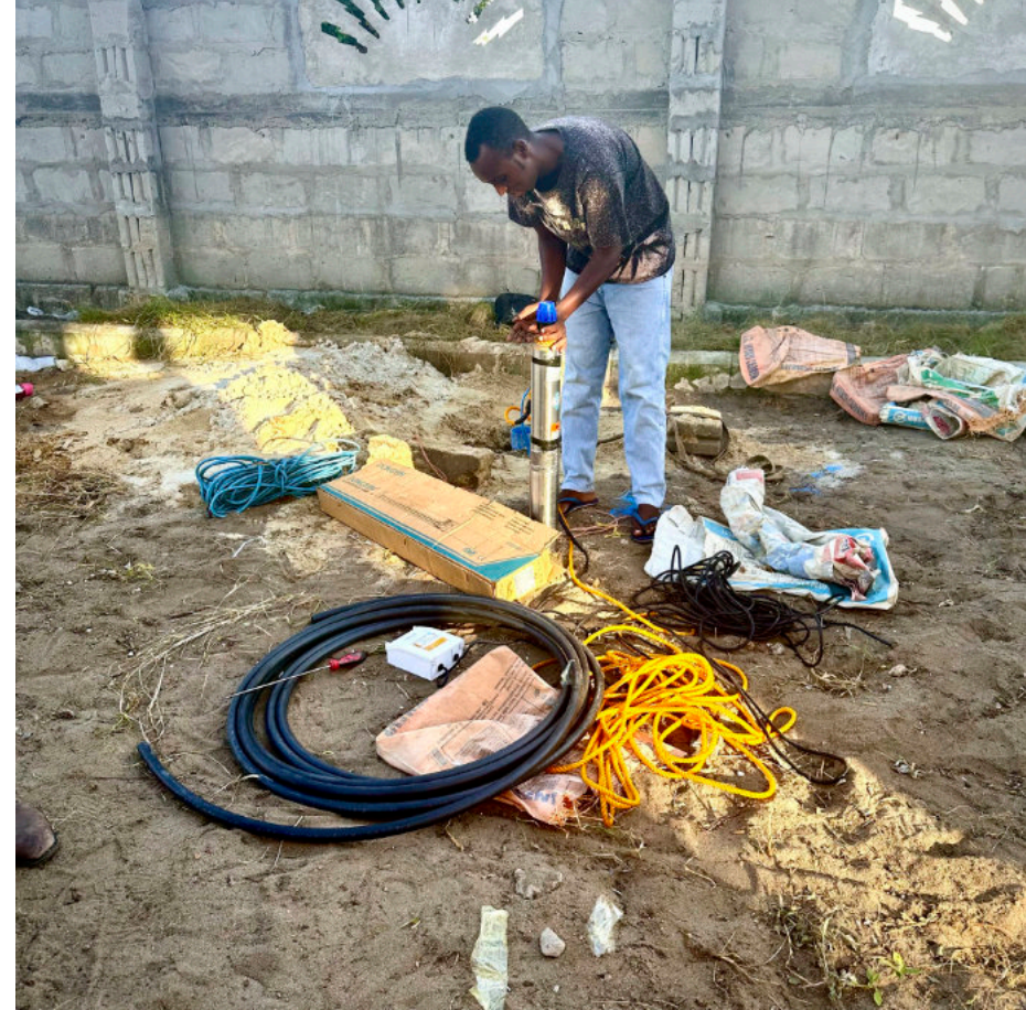
Die Wasserpumpe für die Wasserversorgung aus dem Grundwasser in ca. 10m tiefe wird installiert.
